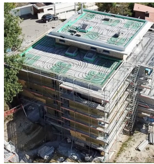
Verlegung der externen Kollektorkreisläufe auf einem Flachdach
