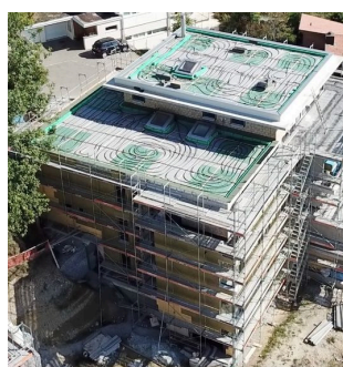
Instalación de los circuitos externos de captación en una cubierta plana
