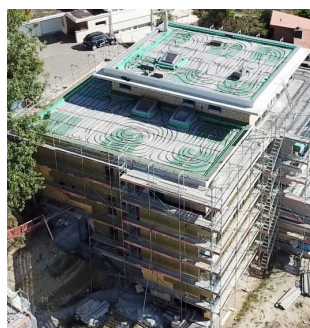
Pose des circuits externes de captage sur un toit plat
